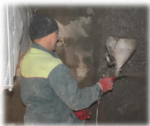
Рис. 5 Механический способ нанесения состава КАЛЬМАТРОН
