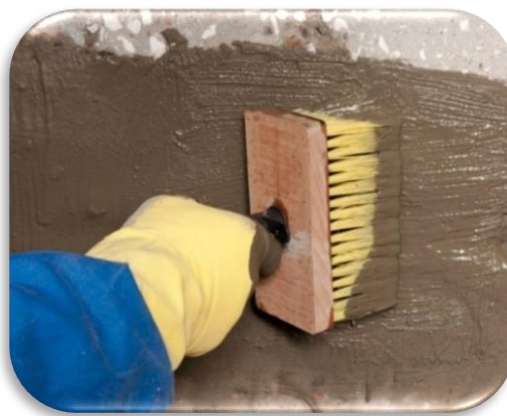
Рис. 6 Ручной способ нанесения состава КАЛЬМАТРОН
