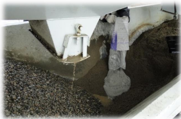
Рис. 3 – Введение добавки КАЛЬМАТРОН-Д в условиях бетонного завода (РБУ)
