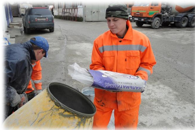
Рис. 4 – Введение добавки КАЛЬМАТРОН-Д в миксер
